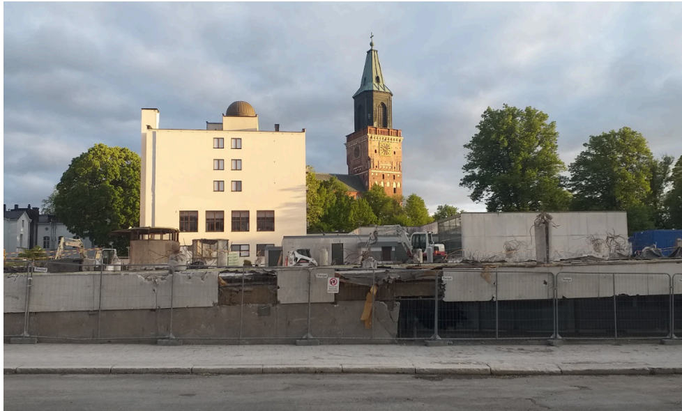
Bild 15. Gadolinia, sommaren 2023, då nästan hela byggnaden redan var riven. Den nya byggnaden kommer att byggas ovanpå källaren och bottenvåningen till det gamla Gadolinia.
