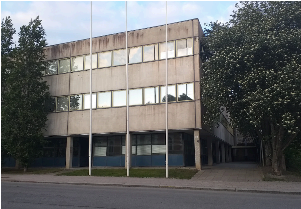
Kuva 15. Axelia rakennettiin halvalla; rakennus edustaa tyypillistä 70-luvun betoni- ja lastulevy-arkkitehtuuria.
